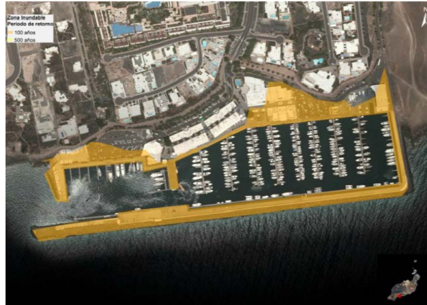
Figura 37. ES123_ARPSI_0014: Puerto Calero.
